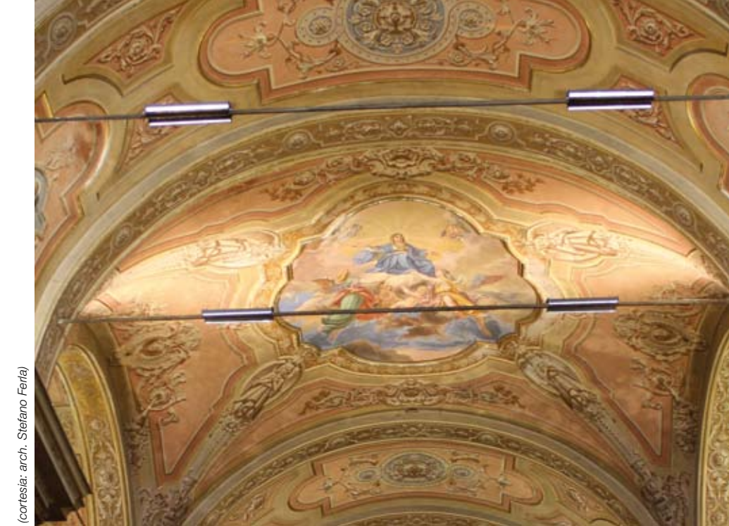
Figura d - Dettaglio tecnico relativo al fissaggio delle barre a LED sulle catene metalliche
