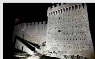
Effetto luminoso ottenuto con fascio asimmetrico
